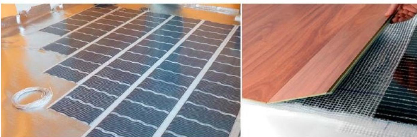
Между стеной и покрытием нужно оставить небольшой зазор – на случай расширения покрытия при нагревании.
